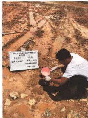
U1 地下水采样
