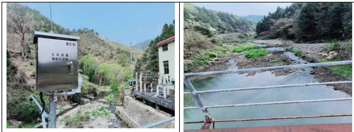
图 5-1 乐昌华东水电站最小生态下泄流量现场照片
